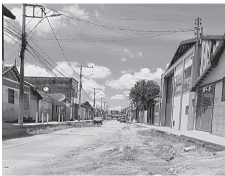
Rua Ismael Faustino, no Paracatuzinho: Piçarra foi removida para garantir maior longevidade à pavimentação asfáltica
