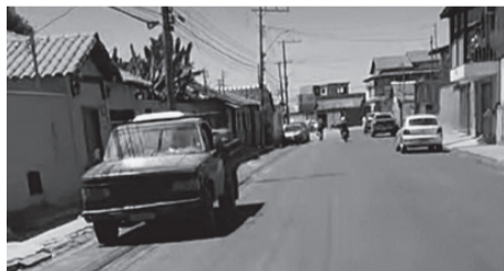
A nova pavimentação asfáltica da Rua Ismael Faustino, no bairro Paracatuzinho
